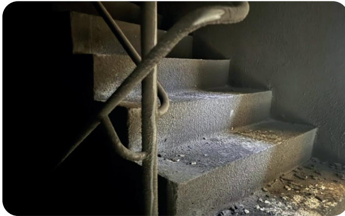
Fotoğraf 2. Yangın Sonrası Yangın Merdivenin Durumu (internet)
