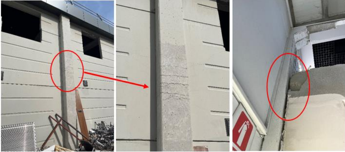
Şekil 5. Tek katlı prefabrik betonarme dış cephe kolonunda "Kısa Kolon" kusuru nedeniyle hasar yaşanması (60 x 60 cm'lik kesite sahip)
